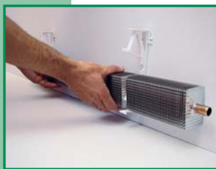
Einlegen des Heizelementes
