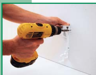
Befestigung der Halter
